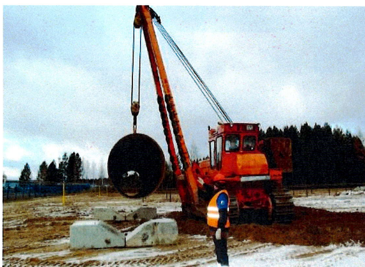
Рис. 2 Практика машинистов трубоукладчика
