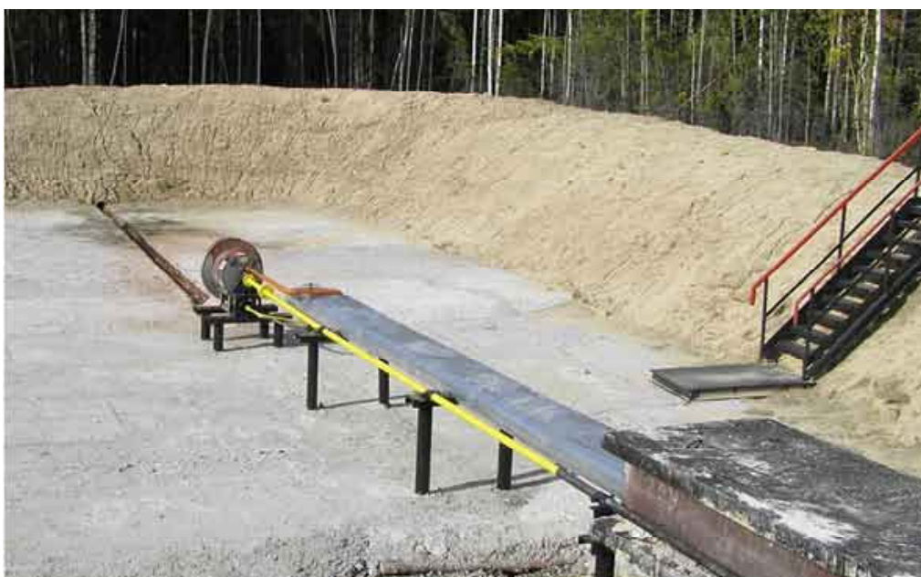
Горизонтальная факельная установка для термического обезвреживания продуктов очистки газа Комсомольского ЛПУМГ
