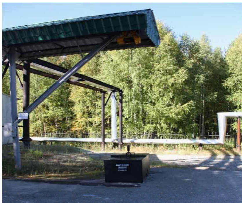
Место накопления отходов службы связи Комсомольского ЛПУ МГ
