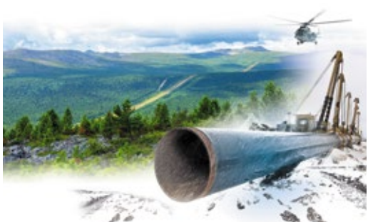
СОВЕЩАНИЕ ПАО «ГАЗПРОМ» ПО ВОПРОСАМ ЭКСПЛУАТАЦИИ ЛИНЕЙНОЙ ЧАСТИ МГ Эффективность работы газотранспортной системы стр. 2
