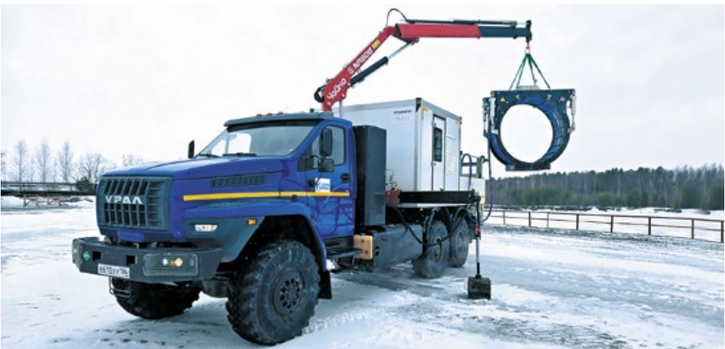
Разработка, значительно повышающая производительность технологии нанесения ТУМ при ремонте участков МГ
