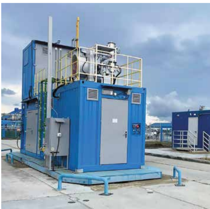
Блок компримирования природного газа в г. Нижней Туре
