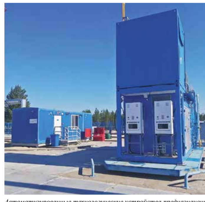
Автоматизированные технологические устройства предназначены для заправки транспорта, работающего на метане
