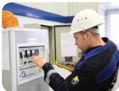
**ИНЖЕНЕР ПО ЭЛЕКТРОХИМИЧЕСКОЙ ЗАЩИТЕ** определяет защищенность трубопроводов от коррозии, анализирует состояние изоляции труб, занимается эксплуатацией средств электрохимической защиты. Инженер руководит работами по электрометрическим измерениям защитных потенциалов системы катодной защиты на подземных трубопроводах.
