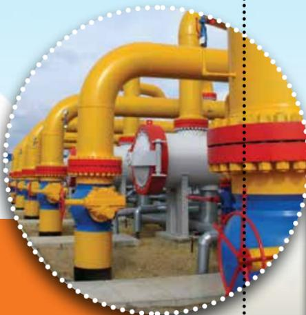
Осушка газа необходима для того, чтобы содержащаяся в газе влага не конденсировалась в газопроводе, не скапливалась в его низинных участках, уменьшая проходное сечение трубы, что существенно повышает риск образования гидратных пробок. Осушку газа осуществляют, пропуская его через специальные поглотители влаги, называемые адсорбентами, либо охлаждая газовый поток, чтобы пары влаги, содержащейся в газе, конденсировались в специальной установке и затем удалялись из нее.
