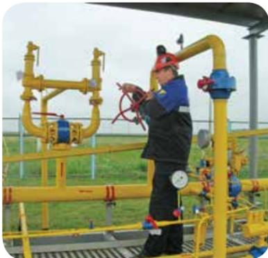
**ОПЕРАТОР ГАЗОРАСПРЕДЕЛИТЕЛЬНОЙ СТАНЦИИ** (ГРС) обеспечивает заданный режим работы ГРС, занимается обслуживанием приборов регулирования, установок очистки, подогрева, одоризации газа. Проводит проверку оборудования с целью выявления неисправностей и утечек газа. Участвует в проведении ремонтных и планово-предупредительных работ. В аварийных ситуациях по команде диспетчерской службы ЛПУМГ выполняет оперативные действия. Ведет записи в оперативных журналах. Знает схему ГРС и всех коммуникаций.
