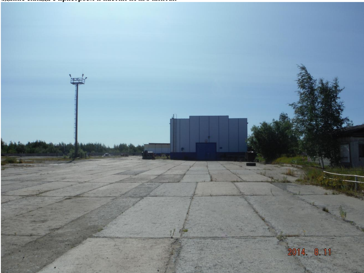
Здание склада с пристроем и настил из ж/б плиты.
