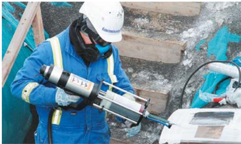
Нанесение эпоксидной изоляции Canusa с помощью мелкокапельного распылителя
