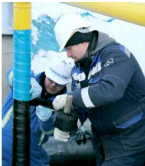
Нанесение изоляции Wrapid Bond на переходе трубопровода «земля-воздух»
