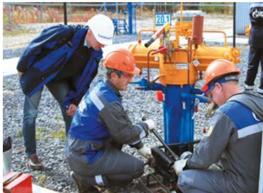
Проверка работы запорной арматуры
