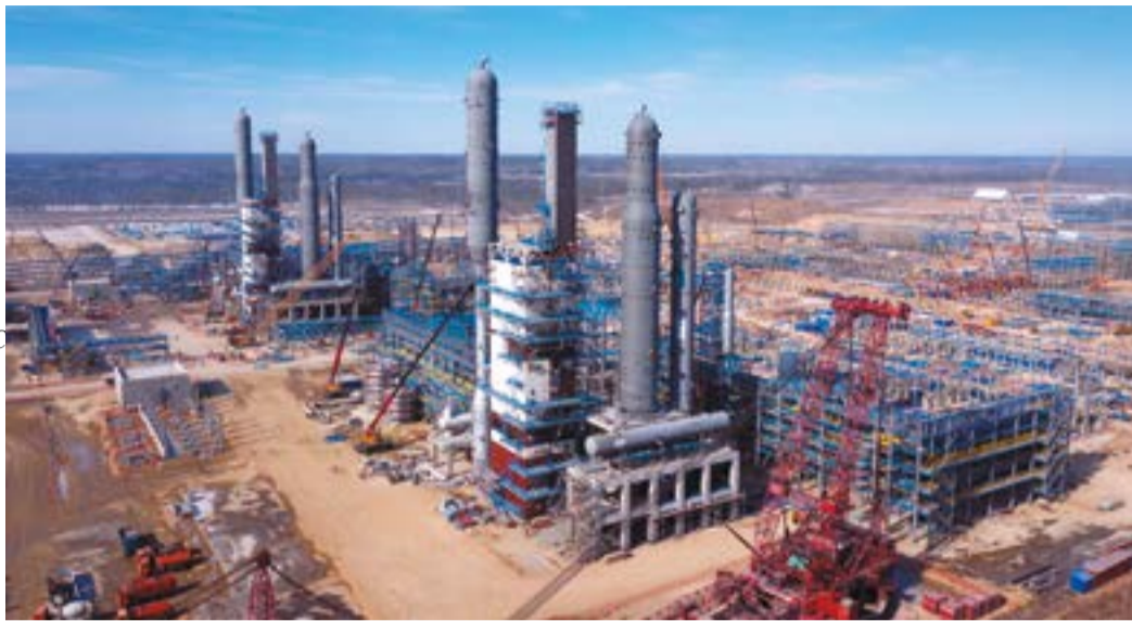
Строительство Амурского газоперерабатывающего завода
