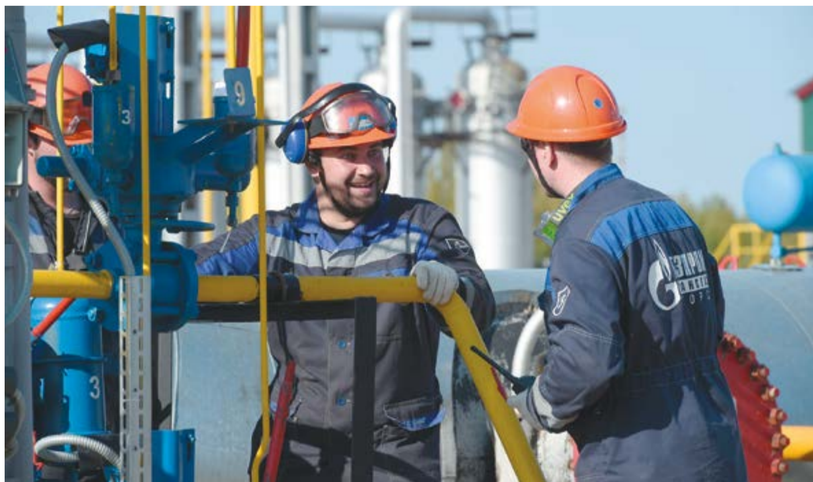
Обслуживание запорной арматуры цеха
