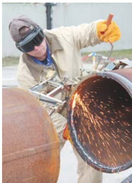
Работа с повышенной опасностью: подготовка стыка к сварке
