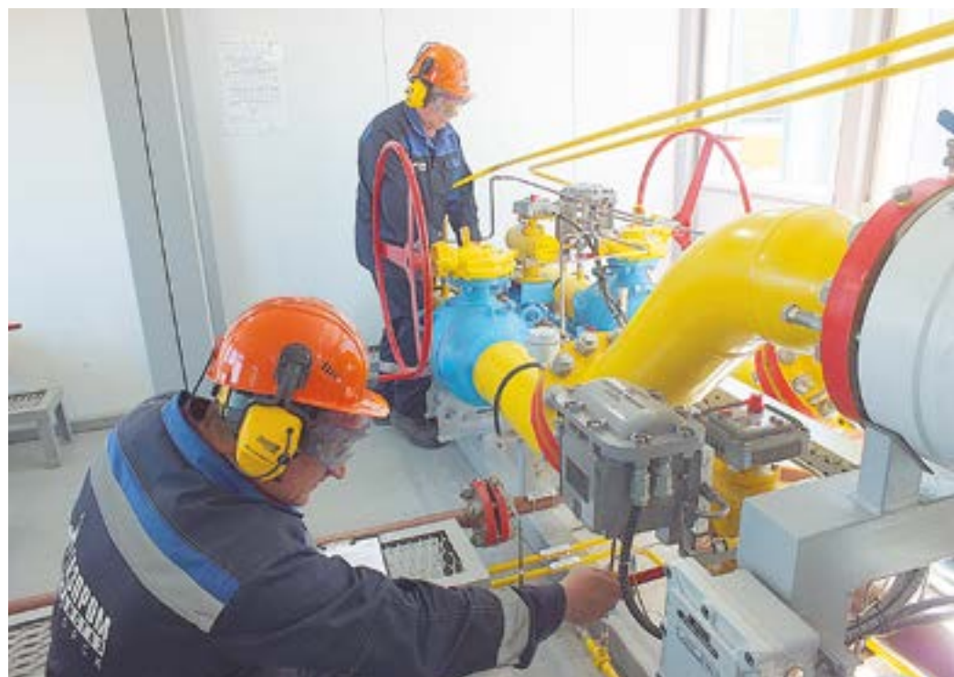
Обслуживание оборудования на ГРС
