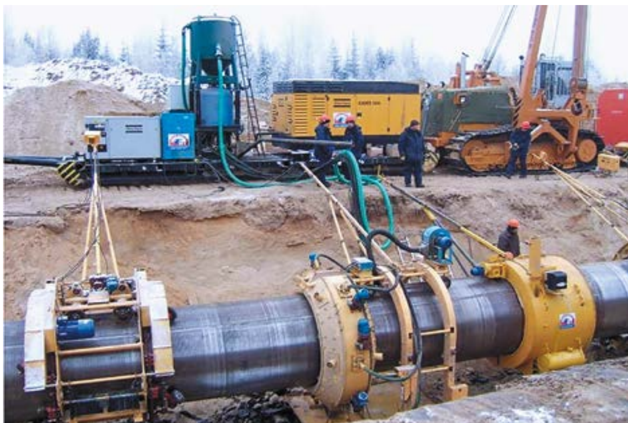
Мобильная компрессорная установка в работе
