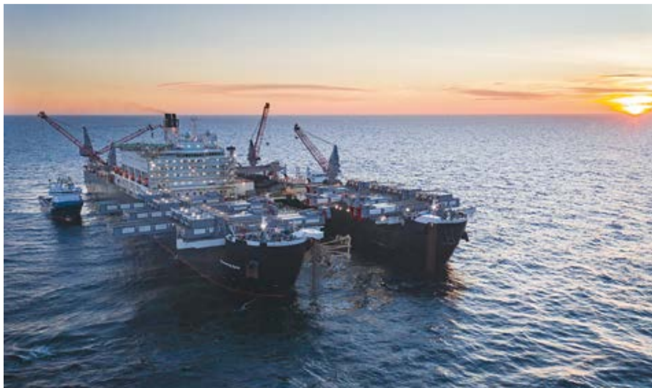
Строительство морской части газопровода «Северный поток - 2»
