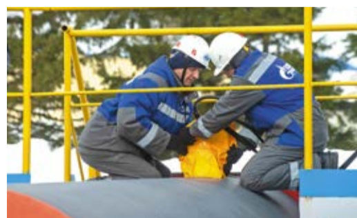
СТЕНДОВЫЕ ИСПЫТАНИЯ ВГУ В КОМСОМОЛЬСКОМ ЛПУМГ
