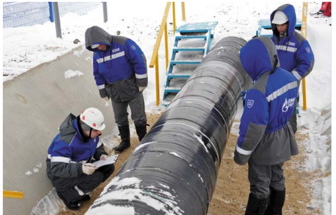
Выполнение практического задания «Контроль качества нанесенного защитного покрытия»
