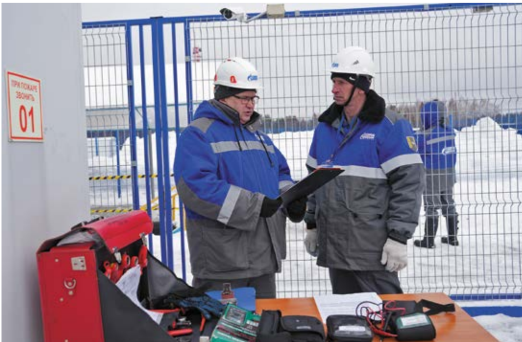
Выполнение задания по техническому обслуживанию средств электрохимзащиты
