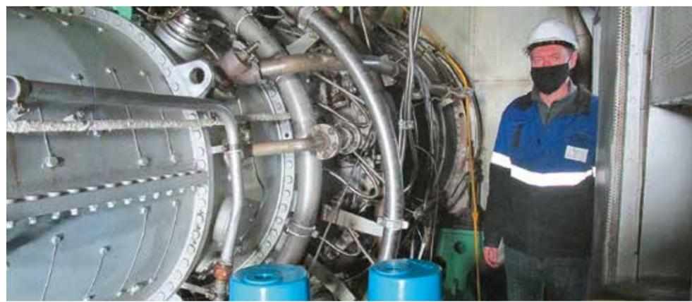
Газотурбинный двигатель типа ДГ-90Л2.1
